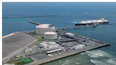
Hitachi LNG Terminal
