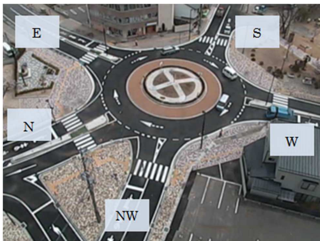
図 5 東和町交差点 (工事後)
