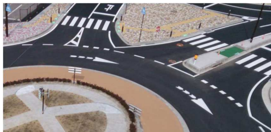
図 6 中央島と環道の路面標示
