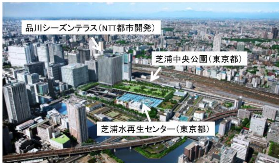
図1. 芝浦水再生センター外観 (出典：東京都下水道局資料)
