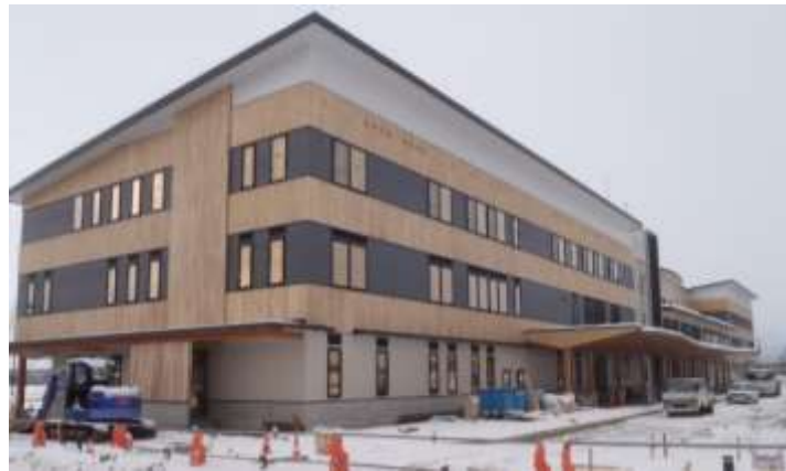
図 1-4 建築中の C 街区新庁舎（出所：筆者撮影）
