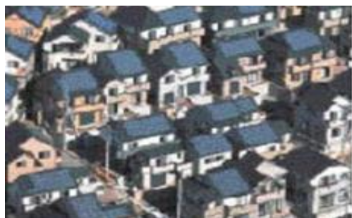
住宅屋根設置
