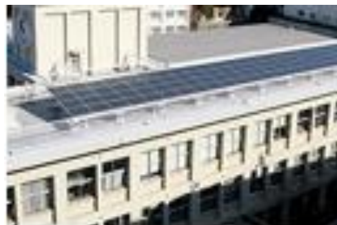
公共施設屋根設置
