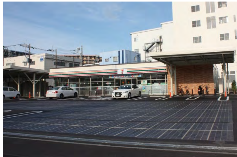
路面型太陽光発電システム (セブン - イレブン相模原橋本台1丁目店太陽光発電システム)
