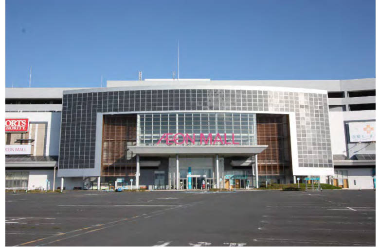
ショッピングモール用太陽光発電システム (イオンモール水戸内原太陽光発電システム)
