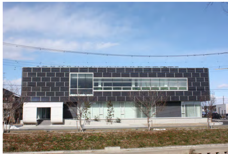
壁面对応型次世代オフィス用太陽光発電システム (イトラスト埼玉太陽光発電システム)
