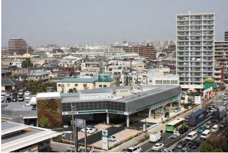
自動車販売店用太陽光発電システム (東京トヨペット葛飾店太陽光発電システム)
