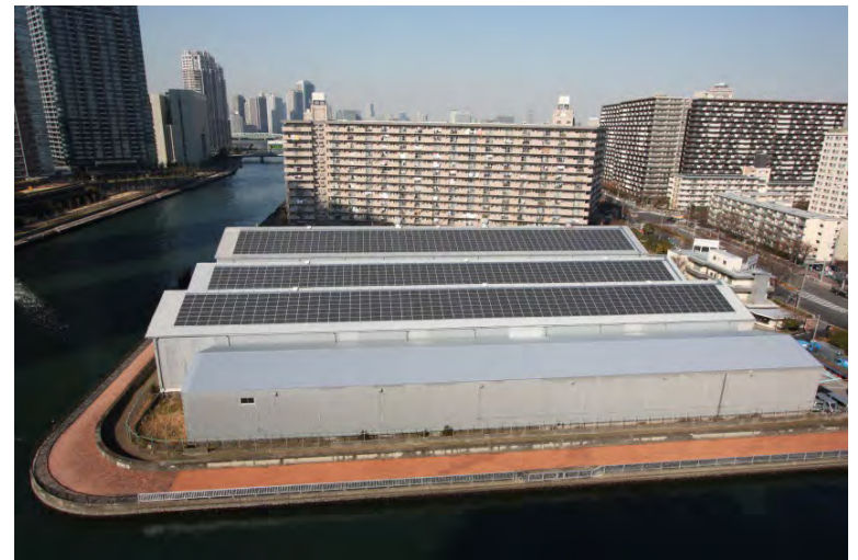
倉庫用太陽光発電システム (テツソートランクルーム太陽光発電システム)
