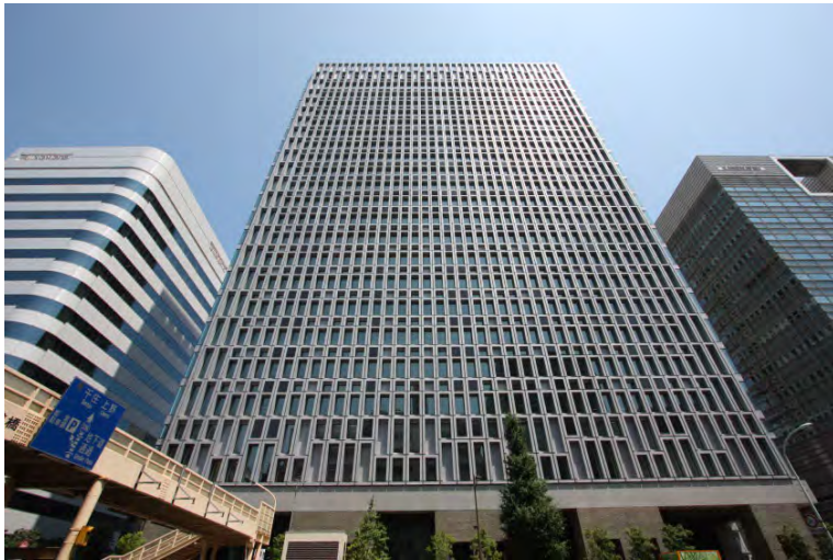
オフィスビル用太陽光発電システム (清水建設本社ビル太陽光発電システム)
