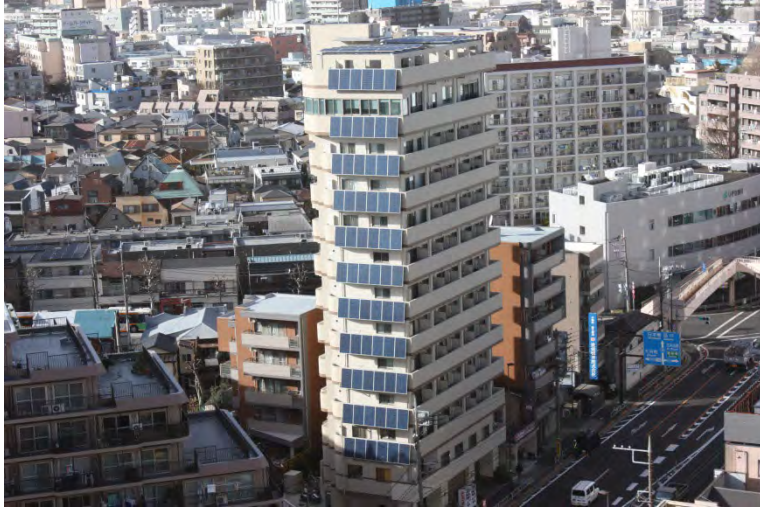
賃貸マンション用太陽光発電システム (アイディ品川XI太陽光発電システム)
