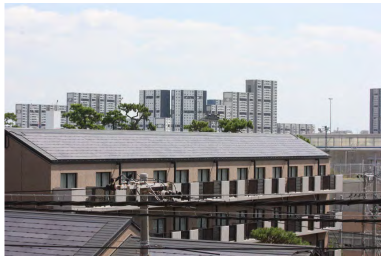
研修施設用太陽光発電システム (「カネカ 未来創造館」太陽光発電システム)
