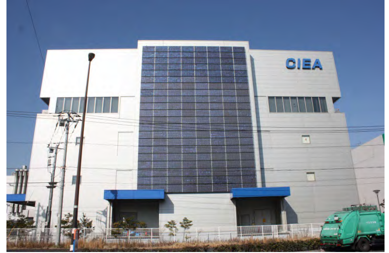
研究施設用太陽光発電システム (実験動物中央研究所太陽光発電システム)
