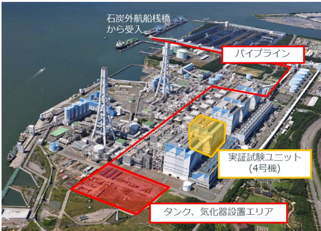
JERA碧南火力発電所 (愛知県碧南市)
