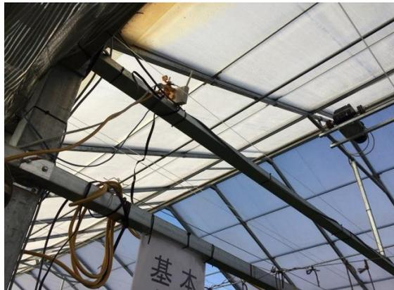
図4 センサーとカーテン開閉装置
