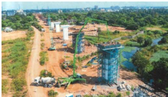
橋脚工事の現場 上：ムンバイから195km地点 下：ムンバイから167km地点
