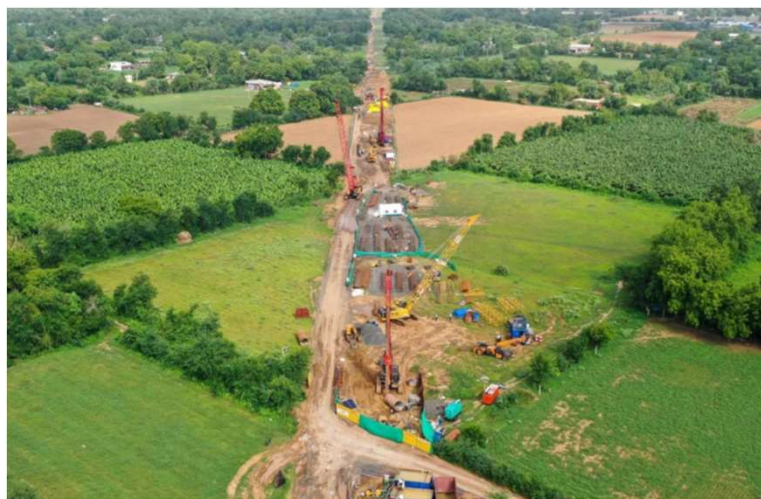
橋脚工事 (ムンバイから434.5km地点)
