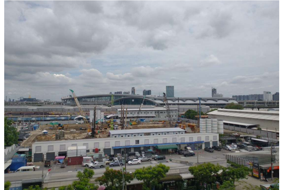
↑ バンズー地区の建設風景
